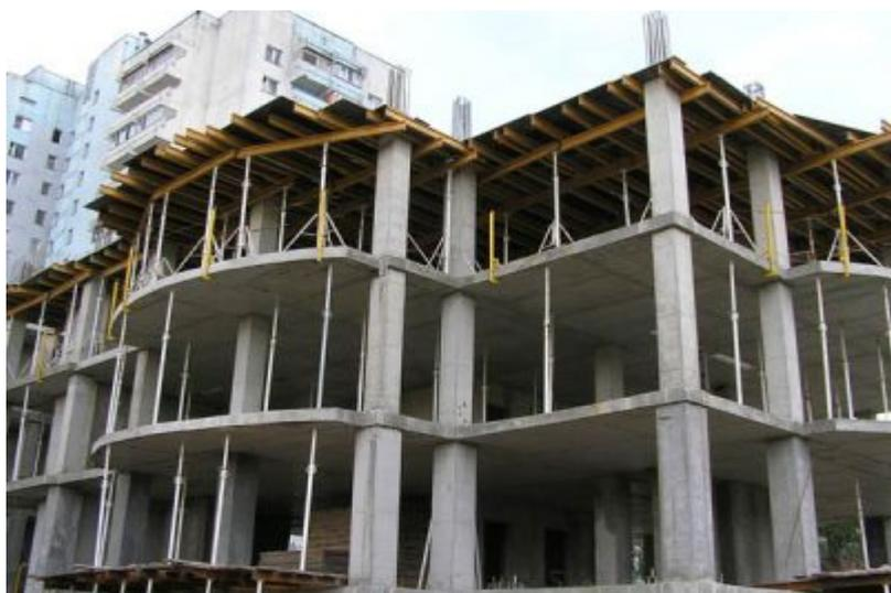
Сегодня технология широко распространилась по монолитным строительным работам. Ранее популярным стало строительство многоэтажных объектов, использующих сборного железобетона, но сравнивая стоимость готового квадратного здания на метр, кирпич не имеет себе равных.
