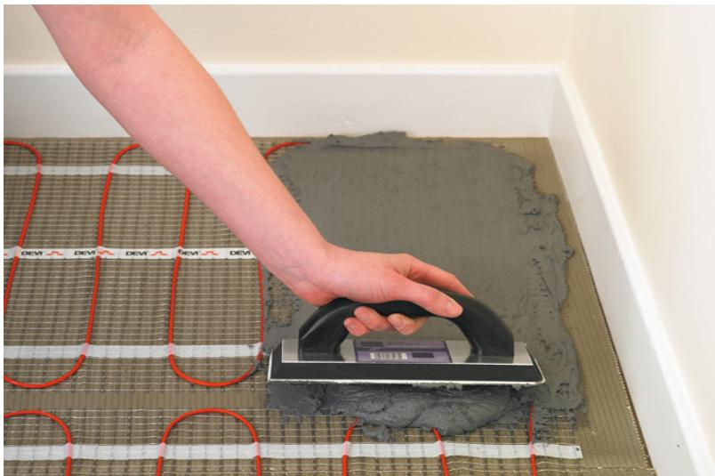
Положить керамическую плитку на пол можно только в том случае, если поверхность для ее монтажа полностью выровнена. Причина наличия такого требования состоит в том, что при присутствии хотя бы небольших неровностей есть опасность возникновения трещин на плитке в результате ее интенсивной эксплуатации. Чтобы получить ровную поверхность, следует провести заливку стяжки.
