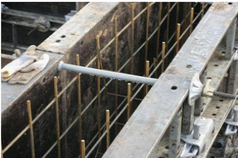
Для того чтобы фундамент стал не только прочным но и долговечным, нужно для него правильно подобрать арматуру для устройства сетки. Если не учитывать маркировку прутков и соответственно диаметр, то риск разрушения основания дома довольно велик. Важно понимать также и то, что арматура из стеклопластика и обычная металлическая отличаются между собой.
