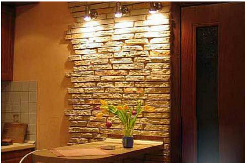
Искусственный камень изготавливается из акриловой смолы, добавляют в него наполнитель и цветные пигменты. Качество этого камня увеличивается после обработки с помощью современных технологий. Таким камнем обрабатывают барные стойки, подоконники, также им можно облицовывать стены. Он может быть различных цветов и имитирует натуральный камень.
