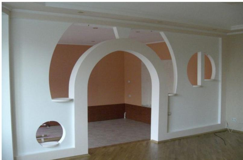
Среди современных материалов, применяемых для проведения строительных и отделочных работ, гипсокартон занимает особенно серьезное место. Дело в том, что для него характерна очень широкая сфера использования. Гипсокартонная панель состоит из трех слоев. В центре расположен гипсовый сердечник, качества которого улучшены различными добавками, а снаружи находятся покрытие из картона.
